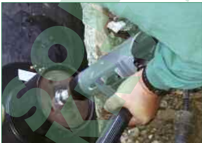
Bild 5: Ausfräsen des Zulaufs zum PE 100 Hauptsammler
