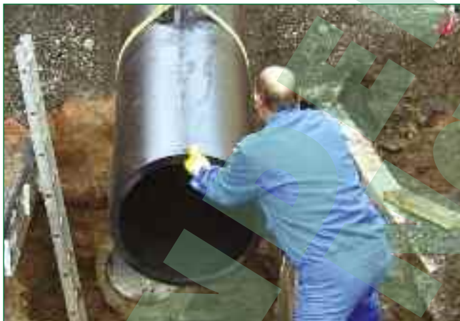
Bild 1: Die Verschweißung der Rohrmodule mittels integrierter Heizwendel
