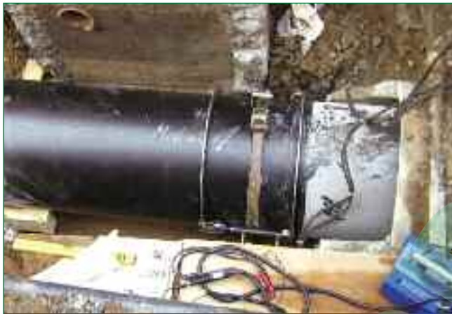
Bild 1: Die Verschweißung der Rohrmodule mittels integrierter Heizwendel
