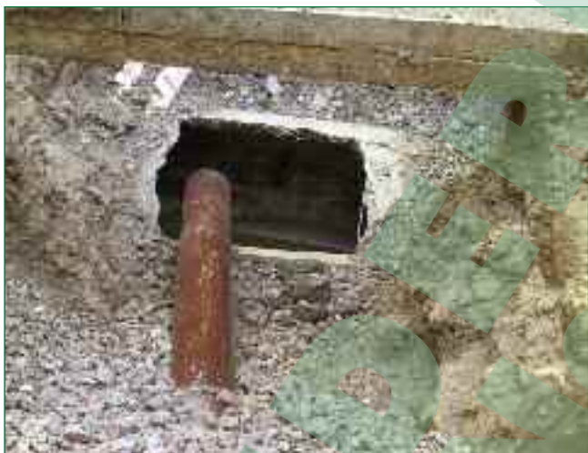
Bild 4: Aufbruch der Betonrohrleitung im Bereich für die Erstellung der zukünftigen Hausanschlusszuläufe
