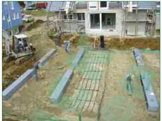
Bild 10: Montage und Verrohrung der Sickermodule
