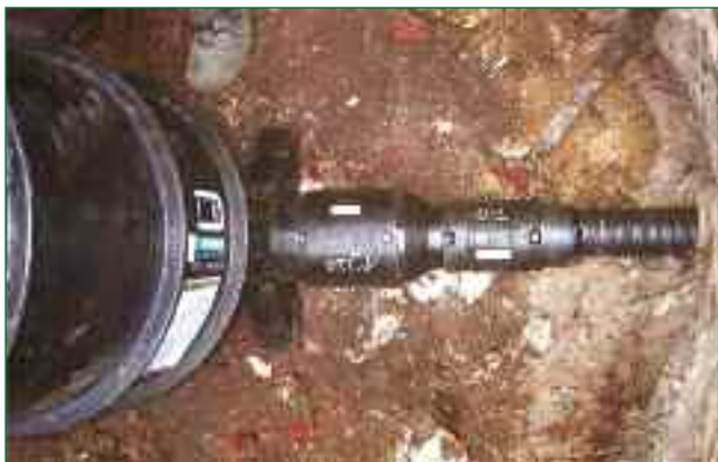
Bild 11: Sanierung der Grundstücksanschlussleitung mit einem Flexorenrohr mit Anschluss an einen PE-Schacht DN 500
