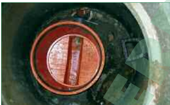
Bild 12: Sanierung der Grundstücksanschlussleitung mit einem Flexorenrohr mit Anschluss an einen Kunststoffschacht DN 400
