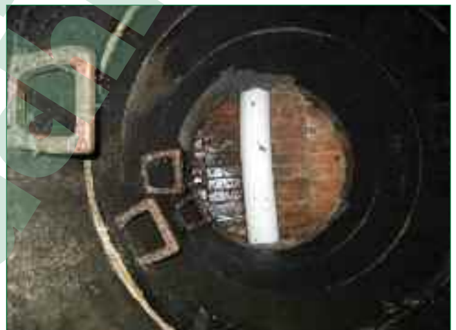
Bild 1 und 2: Einzug des PE-Liners
