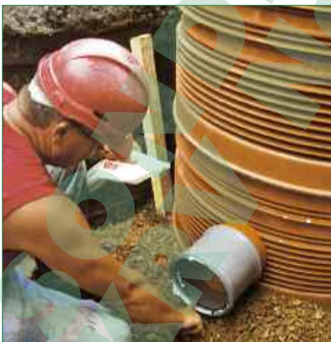
Bild 2: Flexible Doppelmuffe zur Rohrabwinkelung von 7,5°, gut erkennbar: die außenliegenden Rippen
