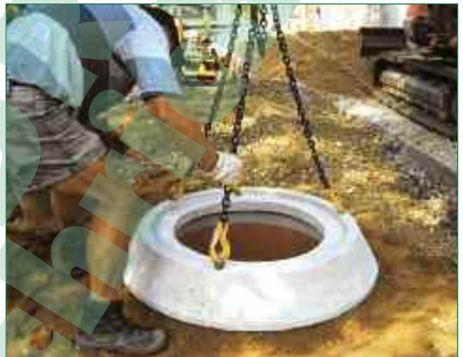
*Bild 5: Betonlastring zur Aufnahme der Schachtabdeckung und Lastabtrag*
