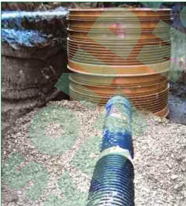
*Bild 4: Unterteil mit Schachtring und angeschlossenem JUMBO KG-Rohr DN 200*
