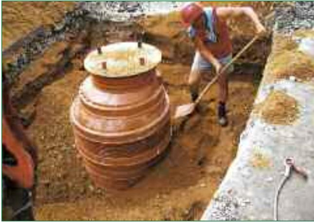
*Bild 3: Schacht M 1000 mit Unterteil, Schachtring und Konus*
