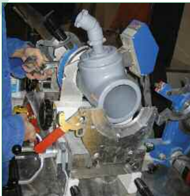
Bild 3: Vorfertigen der Rohrteile mit einer Muffenschweißmaschine
