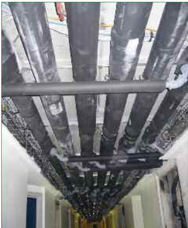
Bild 4: Die fertige Installation im Fairmont Hotel Monte Carlo mit gedämmten Verteilleitungen aus Polybuten
