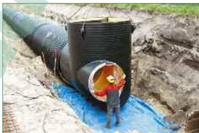
Bild 3: Setzen Übergangsschacht DN 2300 mm
