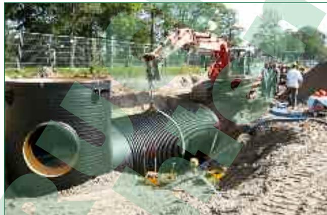
Bild 2: Verlegen der PKS-Rohre DN 2300 mm
