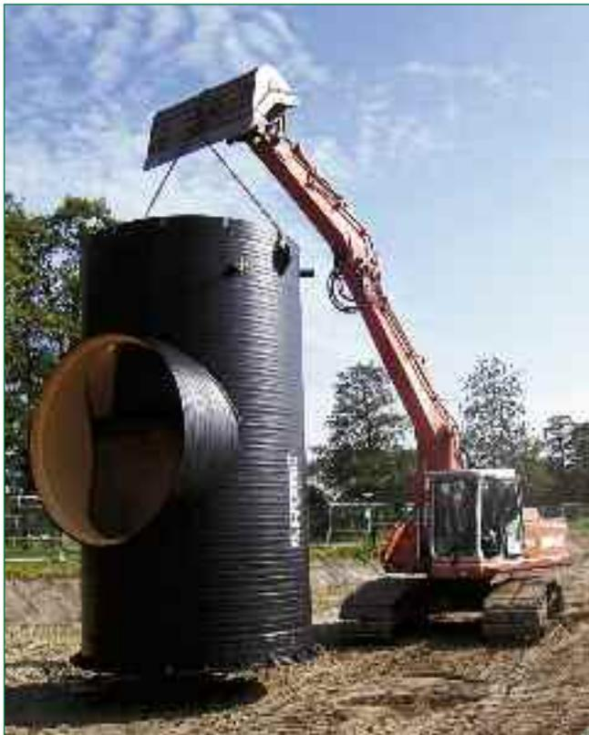
Bild 1: Setzen des Überlaufschachtes DN 2700 mm
