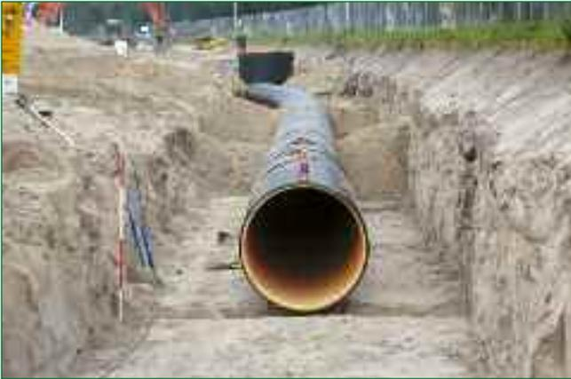
Bild 4: Verlegen der Füllleitung DN 1200 mm
