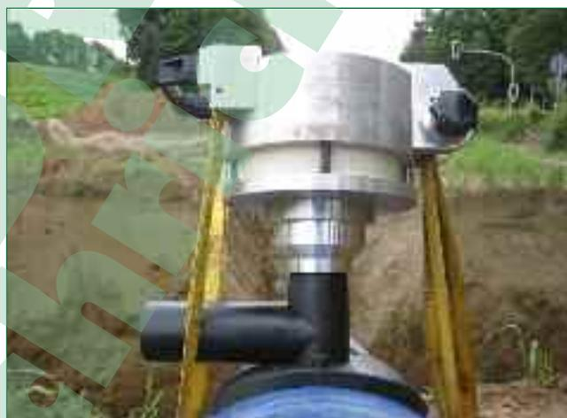
Bild 5: Anschluss an eine Trinkwasserleitung d400 im Top-Loading-Verfahren
