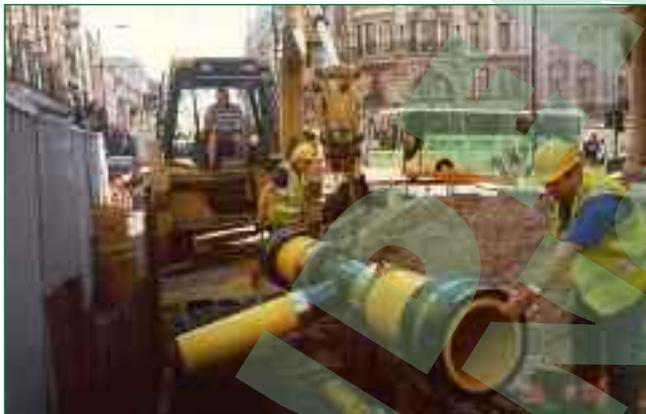
Bild 8: Kostspielig! Einbindung eines Abzweigs in eine Gasleitung d500
