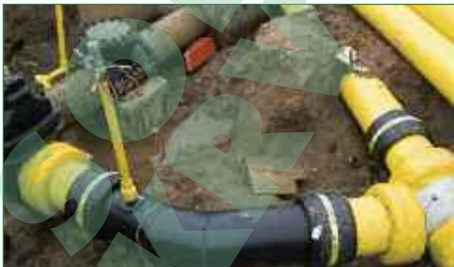
Bild 9: Einbindungen von Armaturen u. Abzweigen in einem Gasleitungsnetz d400-d630 zur Befüllung des Gaskessels
