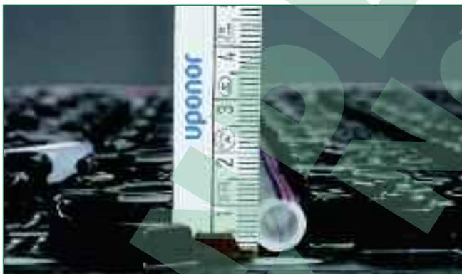
*Bild 4: Spezielle selbstklebende Noppenfolien können im Rahmen der „sanften Renovierung“ direkt auf bereits vorhandenem Estrich, Holz oder Fliesenbelag verlegt werden; die gesamte Aufbauhöhe liegt bei rund 15 mm*
