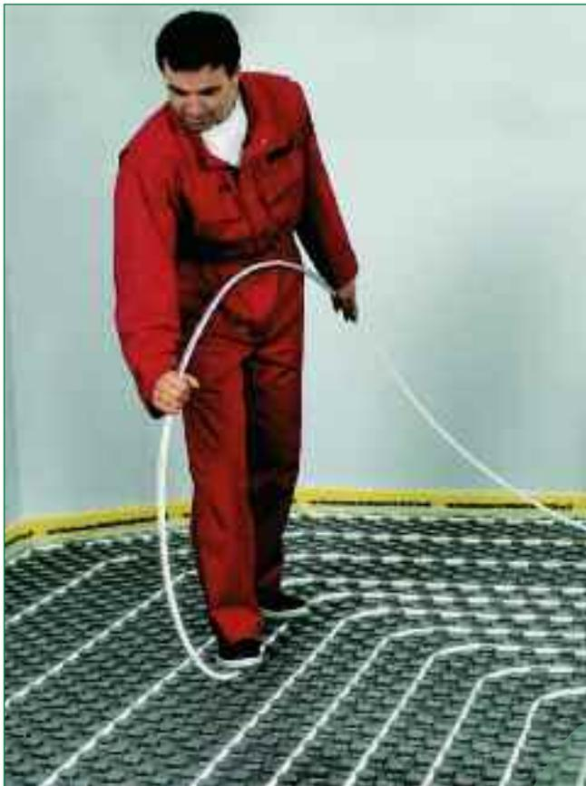
Bild 2: Mit Noppenplattensystemen kann die Rohrverlegung werkzeugfrei in Ein-Mann-Montage erfolgen
