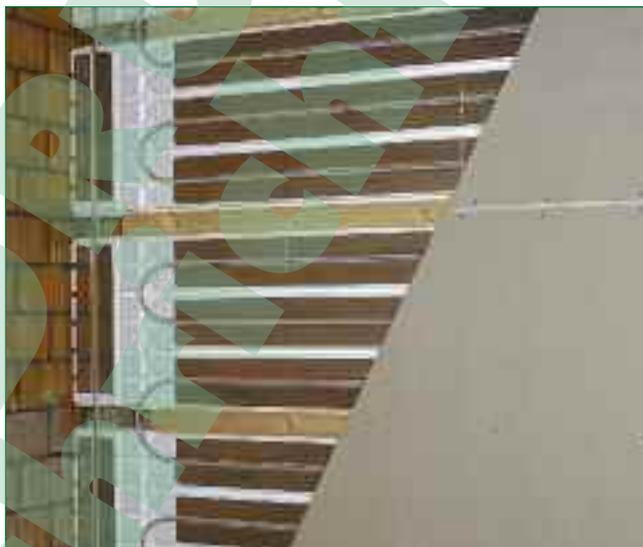
*Bild 5: Sauber an der Wand verlegt: Eine Wandheizung mit Trockenausbauplatten*
