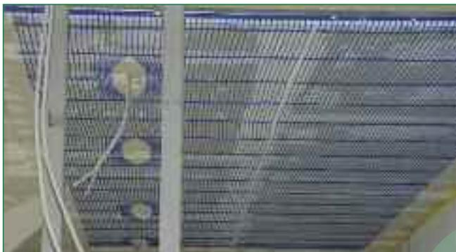
Bild 6: Als Deckenkühlungen entfalten Kapillarrohrsysteme ihre größte Leistungstärke
