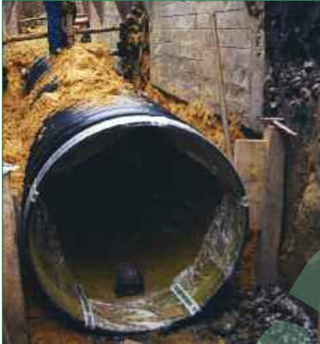
Bild 15: Großrohrverlegung im verbauten Graben
