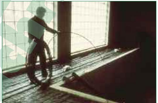
*Bild 2: PEHD-Fußbodenheizungsrohre Ende der 60er Jahre*
