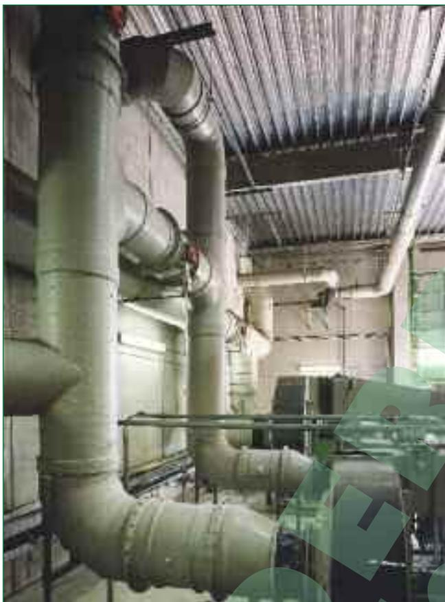
Bild 9: Belüftungsleitungen aus PE in einem Kompostwerk
