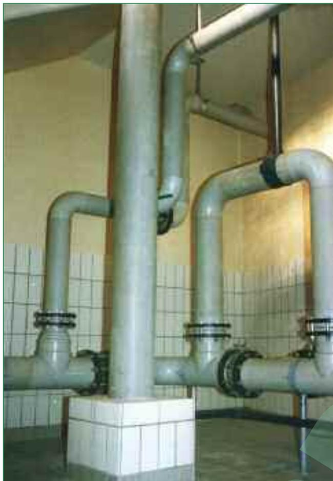
Bild 5: Verrohrung eines Trinkwasserhochbehälters aus PP
