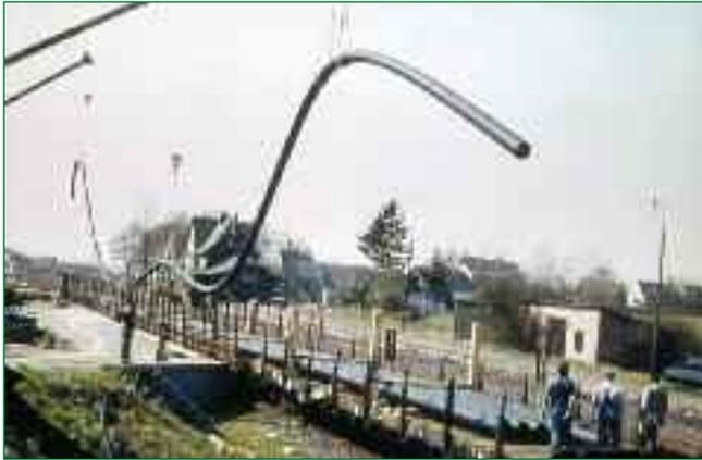
Bild 12: 100 m lange Rohre, DN 300, bei der Verladung auf Waggon
