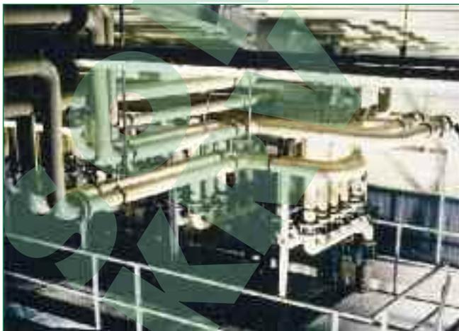
Bild 8: Verrohrung einer Industrieanlage aus PP
