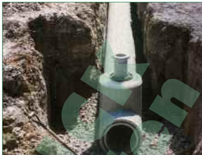
Bild 10: Doppelrohr mit Leckageüberwachung in einem Chemiebetrieb
