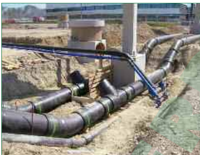
Bild 3: PE-Druckleitung d560: Einsatz der Heizwendelschweißtechnik
