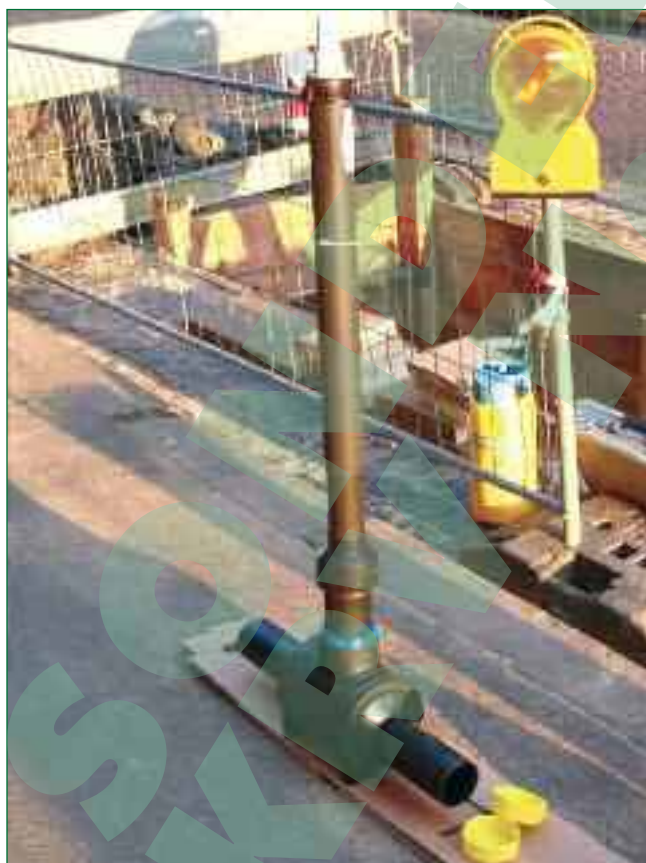
Bild 10: Fertig zum Einbau: FRIALOC PE-Absperrarmatur mit Teleskop-Garnitur FBS
