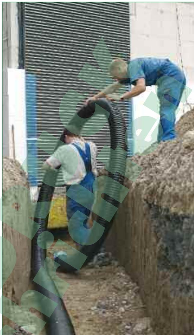
*Bild 3: Dank geringem Gewicht und hoher Flexibilität mit engen Biegeradien sind die vorgedämmten Kunststoffrohre selbst bei anspruchsvollen Trassenführungen schnell verlegt*
