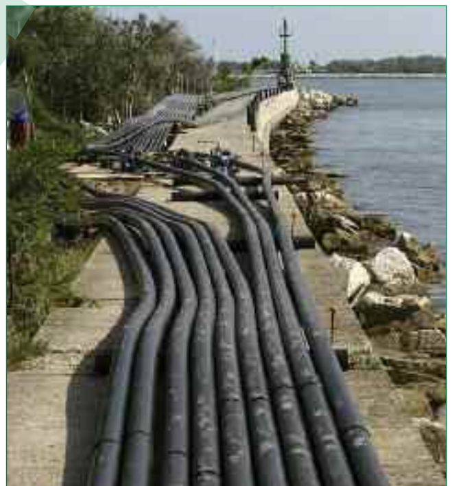
Bild 4: Vorbereitung von 15.000 m PE-Rohren zur Verlegung
