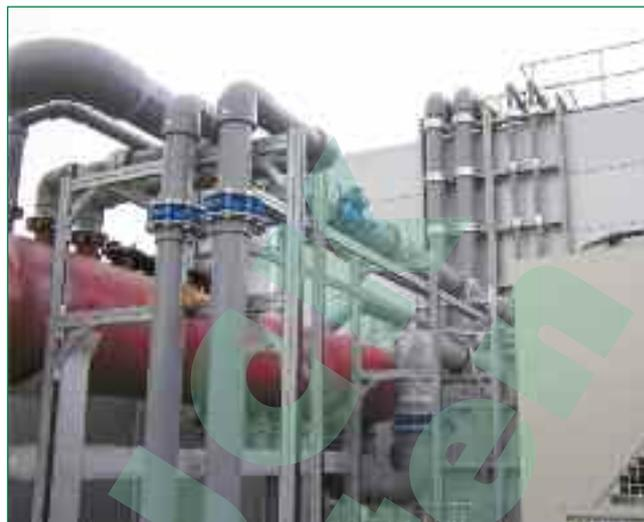
Bild 3: Kühlwasserversorgung für Computerraum aus ABS
