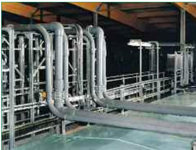
Bild 2: Wasseraufbereitungsanlage mit ABS-Rohrsystem
