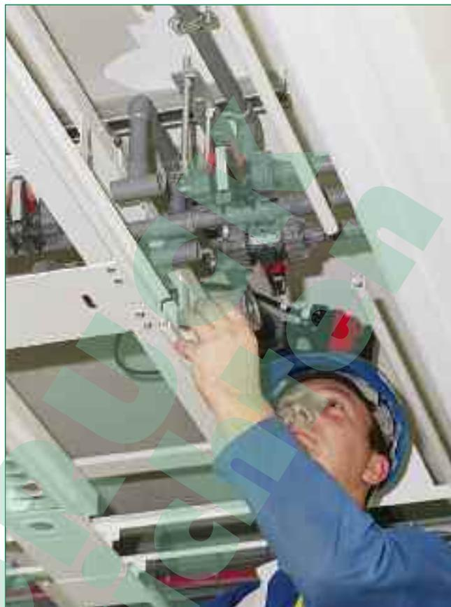
Bild 7: Klimaanlageverrohrung mit ABS
