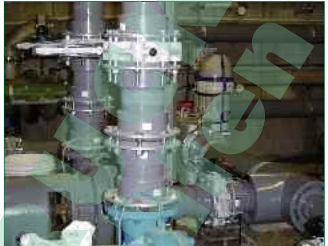
Bild 1: Pumpenverrohrung aus ABS
