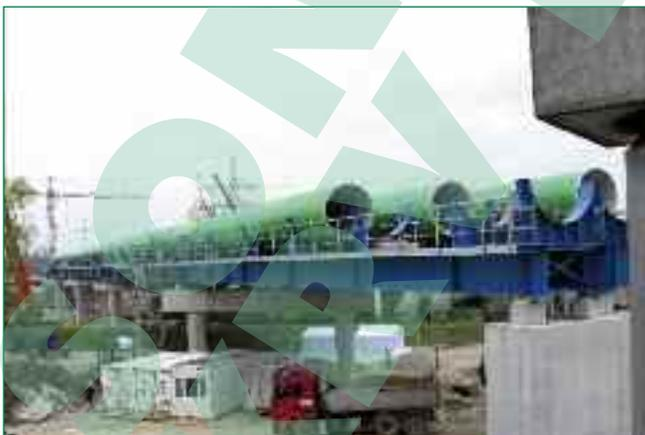
Bild 2: Diese 150 Meter lange Rohrbrücke über die Paar nimmt drei Kühlwasserleitungen DN 2000/2200 aus FLOWTITE-Wickelrohren auf
