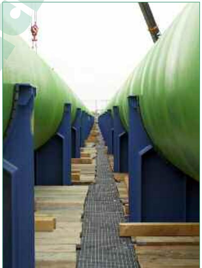
Bild 3: Lagerung der GFK-Rohre in Supporten
