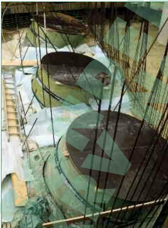
Bild 5: Rohrbögen zum Übergang in die erdverlegte Leitung; es sind bereits die Bewehrungsstähle für das Stahlbetonwiderlager erkennbar
