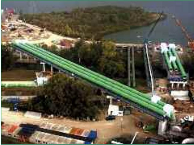
*Bild 6: Luftaufnahme der langen Rohrbrücke mit Zelten für die Laminierungsarbeiten*
