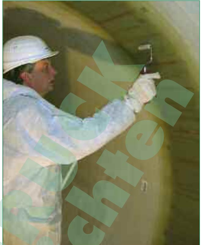
*Bild 7: Laminieren der Rohrverbindungen unter Baustellenbedingungen*
