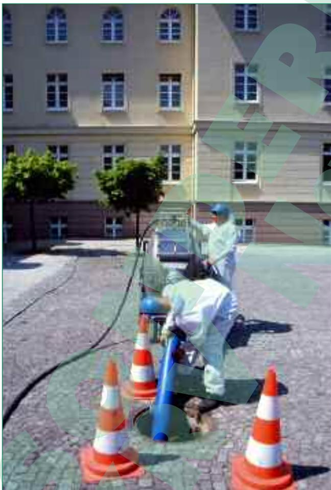
Bild 4: Nach der Inspektion von 1 bis 1,5 Millionen Kilometern Grundstücksentwässerung kommt das eigentliche Problem: Die Sanierung; hier eine grabenlose Sanierung mit einem Schlauchliner-System
