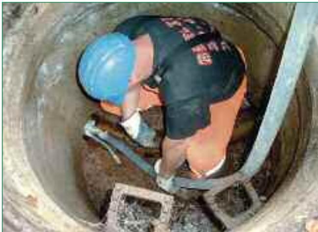
Bild 3: Ob eine Leitung wirklich dicht ist, beweist aber keine Kamerabefahrung, sondern erst eine Dichtheitsprüfung (hier mit Wasser)
