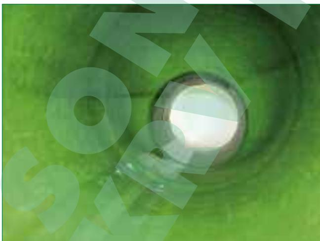
Bild 5: Schlauchliner-Innenauskleidung eines Rohrs mit Dimensionswechsel
