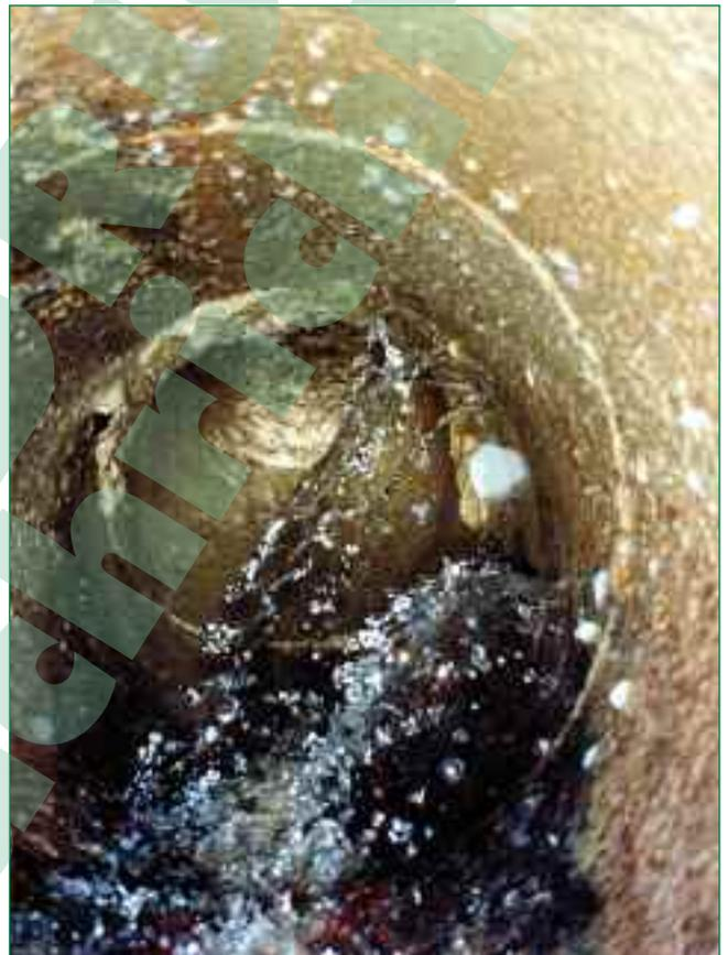
Bild 1: Defekte Hausanschlussleitungen wie diese tragen massiv zur Fremdwasserproblematik bei und müssen daher konsequent erkannt und saniert werden
