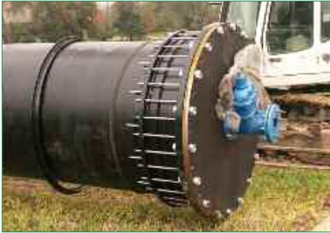
Bild 7: Geschweißter Inliner mit Anschluss für die Druckprüfung
