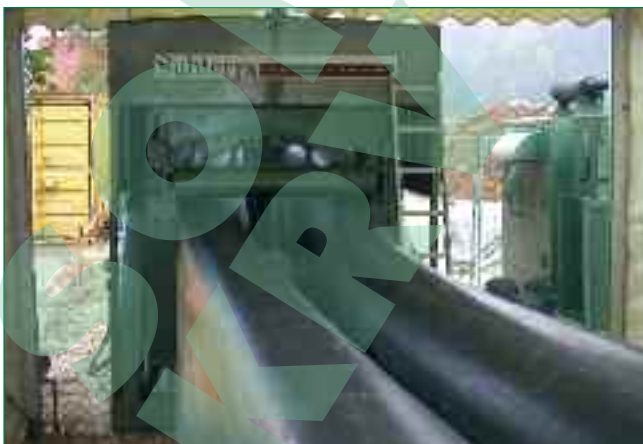
Bild 9: Verformen des PE-Rohres zum c-förmigen Inliner
