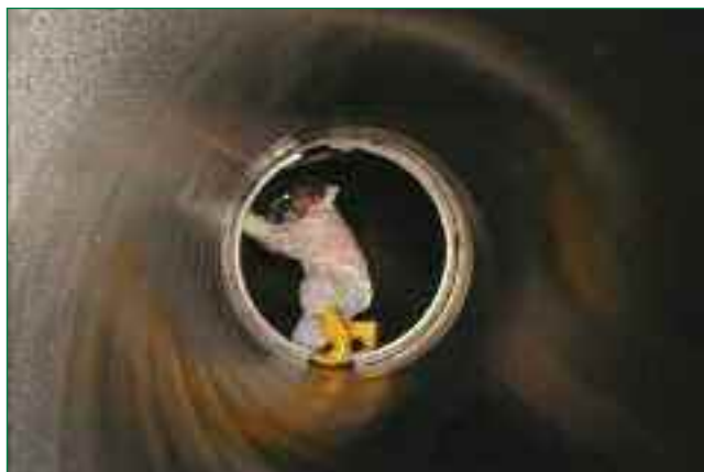
Bild 6: Entfernung des Innenwulstes mit keimfreier Ausrüstung
