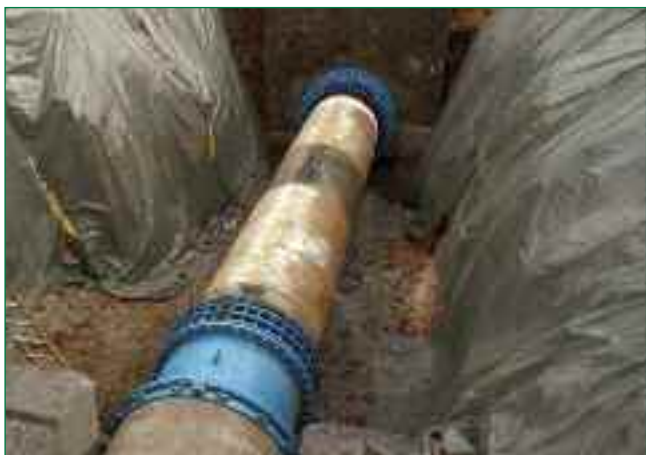
Bild 13: Ziehschacht mit „Linerrip“ im Vordergrund nach Abschluss der Sanierung
