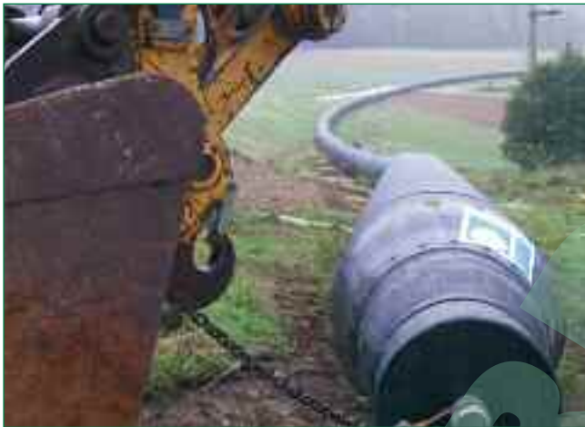
Bild 8: Vorgefertigter Rohrstrang mit Zugkopf
