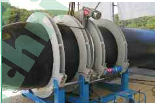
Bild 5: Herstellen des Rohrstranges (Anschweißen des Zugkopfes)
