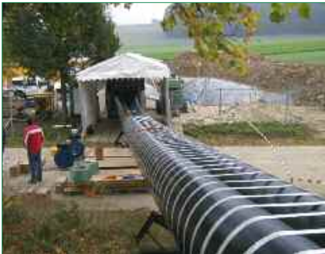
Bild 10: Mit Spannbändern versehener Inliner
