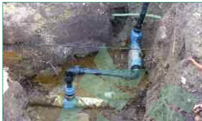
Bild 6: Anwendung PP-H-Klemmfitting und Anbohrschelle
