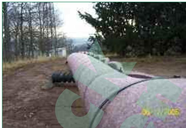
Bild 5: SOLUFORCE – vorgestreckt und zusätzlich mit Steinschutzmatten geschützt
