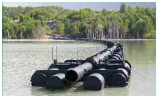
Bild 6: Auslaufleitung für ein Flugasche-Schlacke-Gemisch von einem tschechischen Braunkohlekraftwerk in den Bereich einer Aschedeponie
