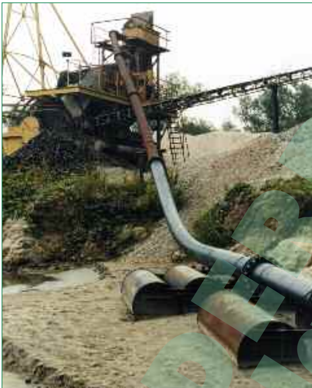
Bild 12: Als Ersatz für die alte Stahlförderleitung wurde eine neue Leitung aus PE-HD auf den alten bestehenden Stahlpontons montiert
