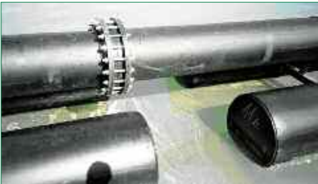
Bild 8: Montage der PE-HD-Schwimmelemente durch klassische PE-HD-Vorschweißbund/Losflanschverbindungen; die eingesetzten Losflansche sind dauerhaft UV- und korrosionsgeschützte Bauteile mit kunststoffummantelten Stahlkernen
