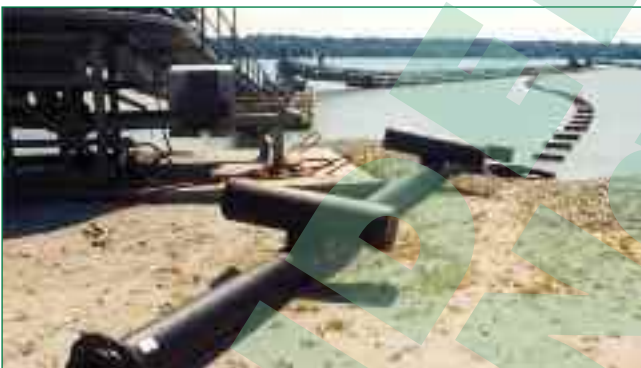
Bild 9: Individuelles Fördersystem aus variabel montierbaren PE-HD Auftriebskörpern und PE-HD Rohren
