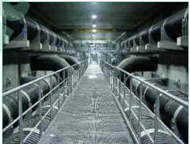
Bild 9: Überblick über den Installationsgang mit verlegten Leitungen DN 1000, DN 1200, DN 1400
