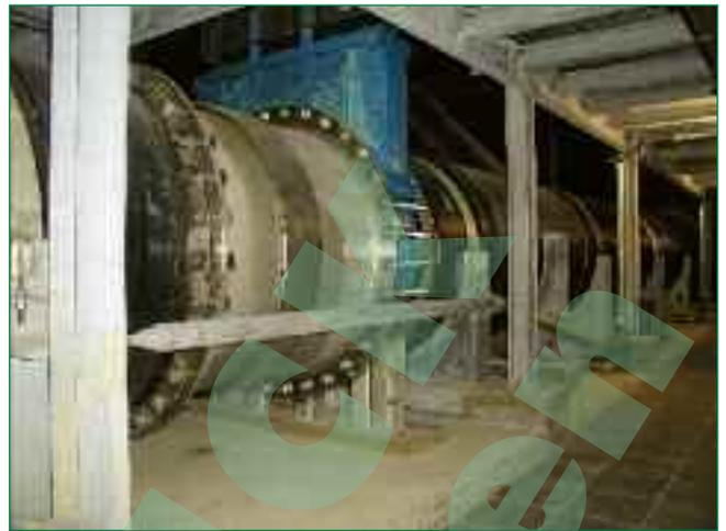
Bild 6: Geflanschtes Rohr mit FF-Stück aus Edelstahl und Kraftumleitung um den Plattenschieber
