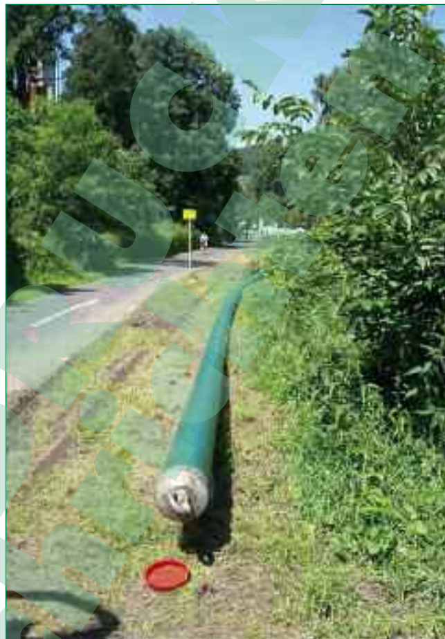
Bild 2: Vorgeschweißter Zugkopf
