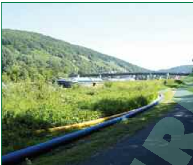
Bild 1: Heizelementstumpfgeschweißte Rohrstränge ausgelegt am Mainufer
