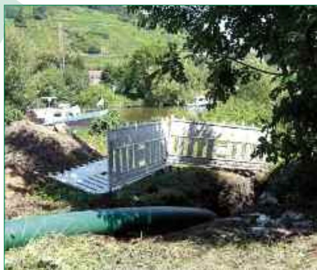
Bild 3: Einzug des PE-Rohres in den Bohrkanal
