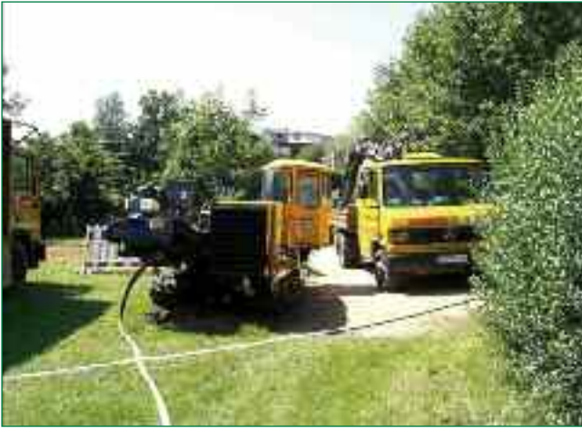
Bild 4: Bohrlafette an der Startbaugrube
