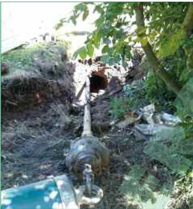
Bild 5: Aufweitkopf mit PE-Rohr
