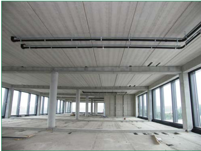
Bild 1: Neben der Hauptentwässerung wurde auch die Notentwässerung mit dem System QuickStream realisiert
