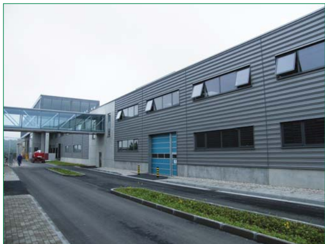
Bild 3: Nach guten Erfahrungen aus dem Vorgängerprojekt setzte der sächsische Autozulieferer UKM auch bei dieser hochmodernen Produktionshalle auf das Unterdruck-Dachentwässerungssystem von Wavin
