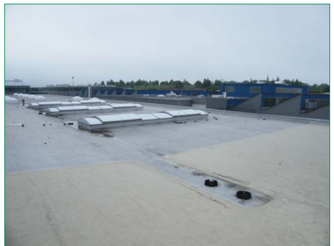
Bild 2: Die Quickstream Dachabläufe „schlucken“ schon bei einer geringen Aufstauhöhe bis zu 17,5 Liter Regenwasser in der Sekunde
