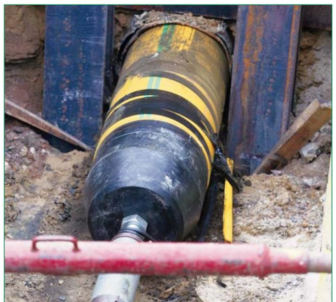
Bild 2: Beginn des Aufweitvorgangs; gut sichtbar: das unter dem Schutzmantel mitgeführte Kabel-Leerrohr
