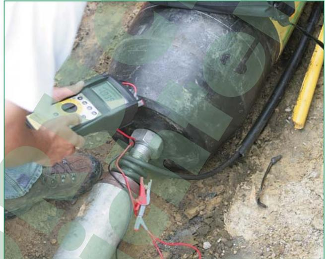
Bild 3: Kontrolle des Isolationswiderstandes des mitgeführten Kabels nach der grabenlosen Verlegung
