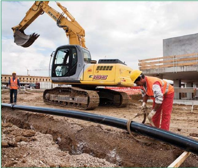
*Bild: PE Wasserrohre aus dem Werkstoff BorSafe LS-H sind gegen Erdbewegungen höchst widerstandsfähig und eignen sich daher besonders für die Wasserleitungen zu den neuen Wohnanlagen der Erdbebenopfer um L’Aquila*
