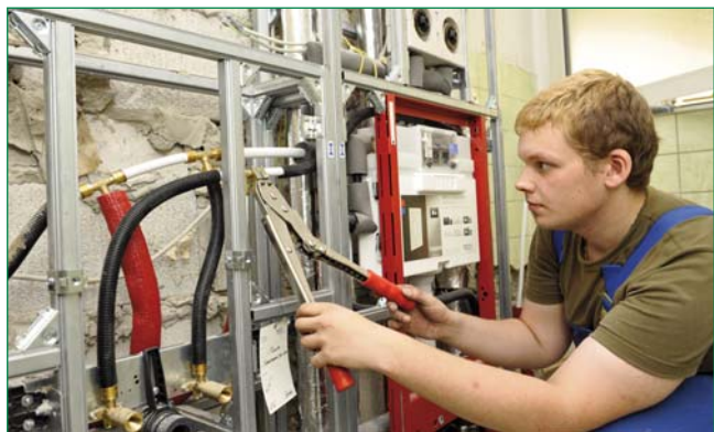
Bild 3: Verpressen der Rohrverbindungen: Die TECEflex-Rohre sind bereits werksseitig in den Registern eingebaut
