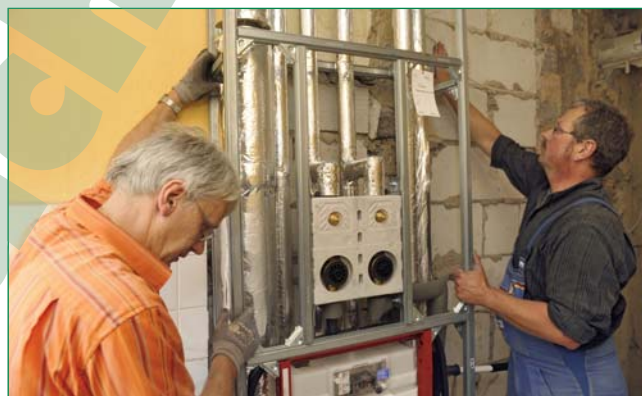
Bild 2: In Position gebracht: Die TECERegister werden da aufgestellt, wo sich die alten Sanitärinstallationen befanden
