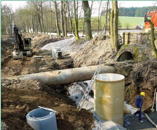
Bild 4: GFK Schacht nach dem Einbau
