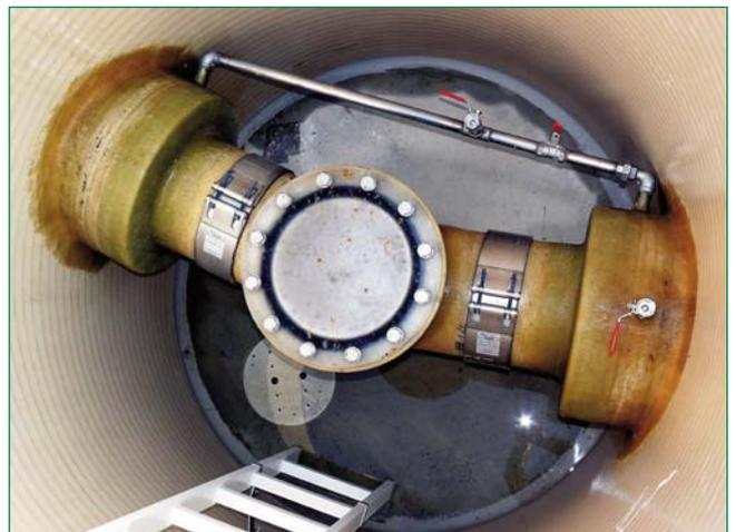
Bild 3: „Innenleben“ der Schächte mit geschlossener Durchführung des Doppelrohrs; von hier aus können die Rohre gewartet und inspiziert werden
