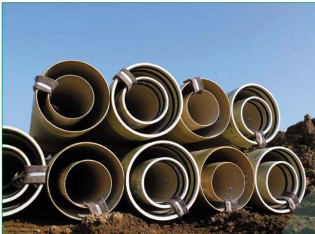
Bild 1: Kompromisslos dicht: Doppelrohre des FLOWTITE Systems vor dem Einbau an den Pfaffenteichen in Hof
