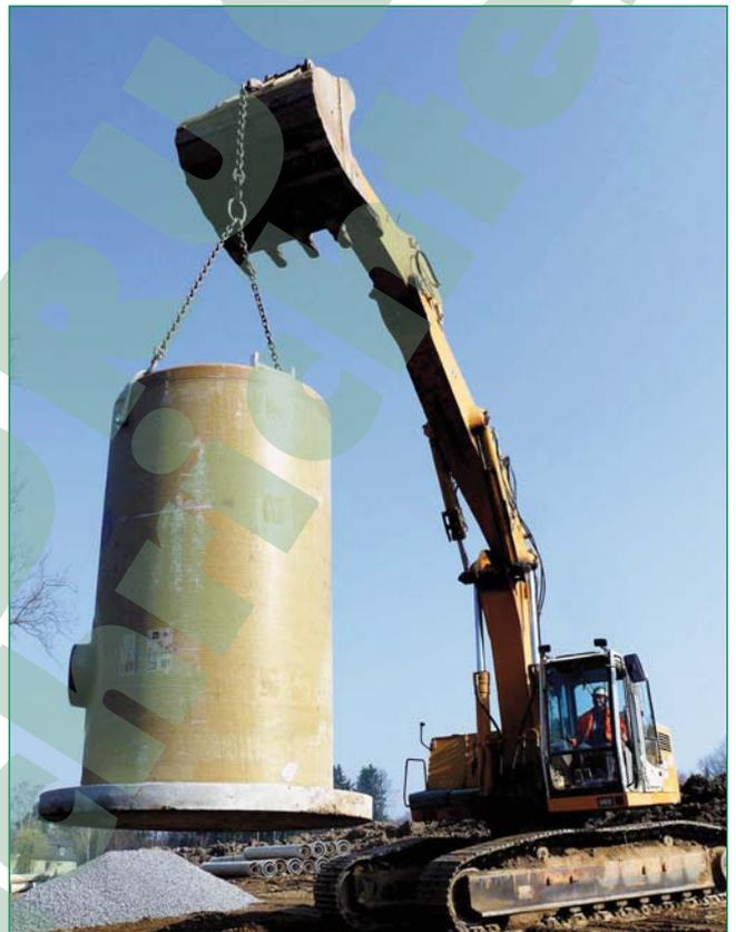
Bild 2: Die in Hof installierten GFK Kontrollschächte mit Anschlüssen für die Doppelrohre: Solche maßgefertigten „Spools“ sind eine der Stärken des FLOWTITE Rohrsystems von Amitech Germany
