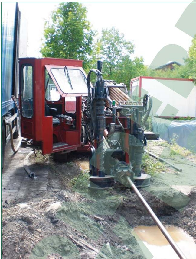
Bild 3: Spülbohranlage bei der Erstellung der Pilotbohrung
