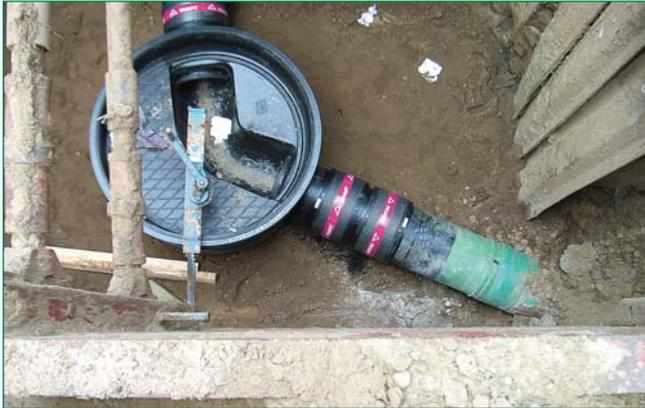
Bild 5: Anschluss eines PE Schachtes an den grabenlos eingebauten Rohrstrang
