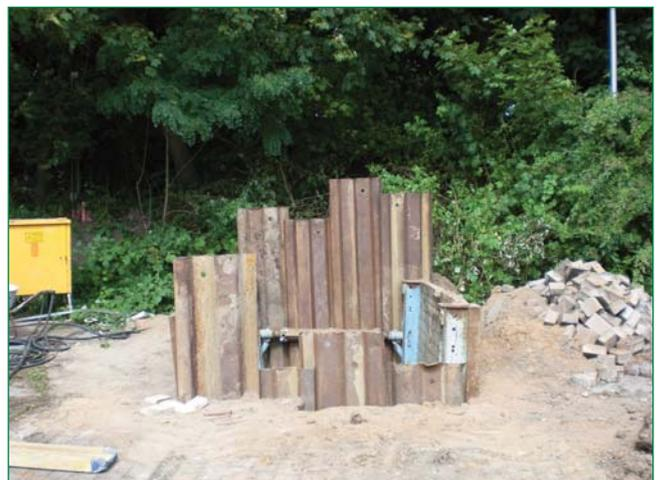
Bild 2: Die Zielbaugrube für den Rohreinbau
