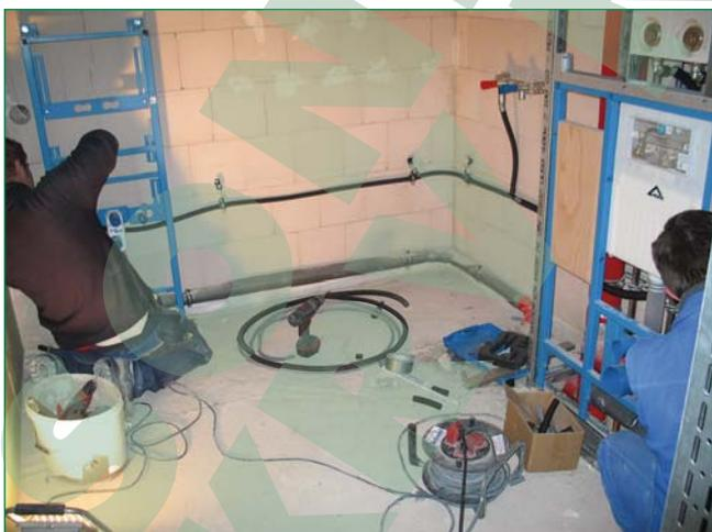
*Bild 3: Teamarbeit: Mitarbeiter der Schmid Haustechnik bei der Anbindung der einzelnen Verbrauchstellen eines Badezimmers*
