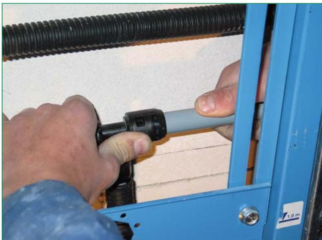
*Bild 2: Gerade in engen Bausituationen ist immer Platz für die nur mit Kraft der Hände ausgeführte FRIATHERM multi Steckverbindingstechnik*
