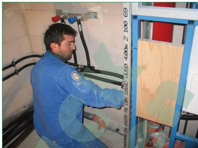
*Bild 4: Schnelle Installation: In 6 Stunden wurden 12 Badezimmer und Küchen sowie ein Sanitärraum mit dem Steckverbindingssystem FRIATHERM multi verrohrt*
