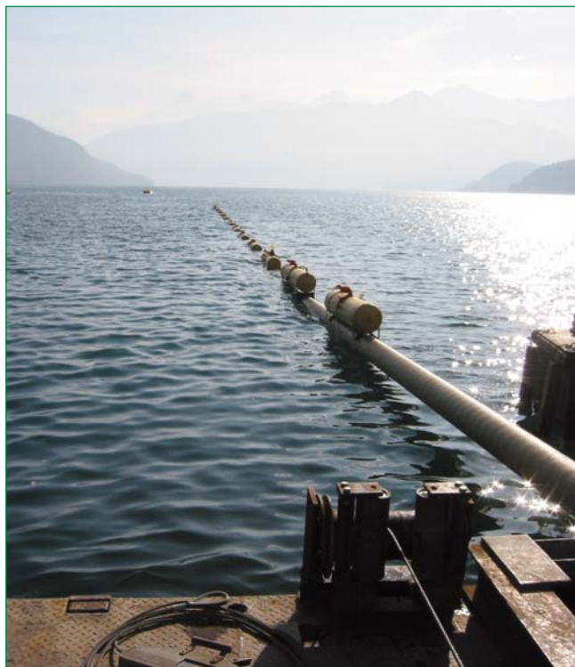
Bild 3: Die Seeleitung wurde auf eine Tiefe von über 200 m auf den Grund abgesenkt
