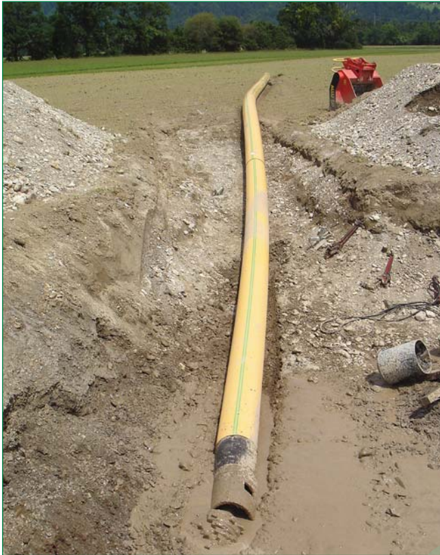
Bild 7: Vorbereitung des Einzugs eines Rohrstranges in die Horizontalspülbohrung
