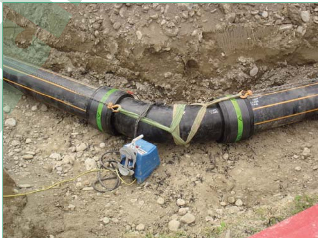
Bild 6: Mit einem FRIAMAT-Schweißgerät wurden die PE Bögen verschweißt
