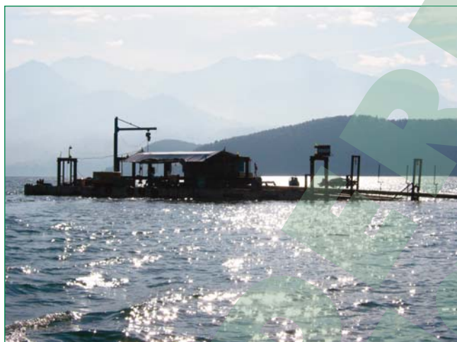
Bild 4: Auf dem Schwimmponton wurde die Seeleitung verschweißt
