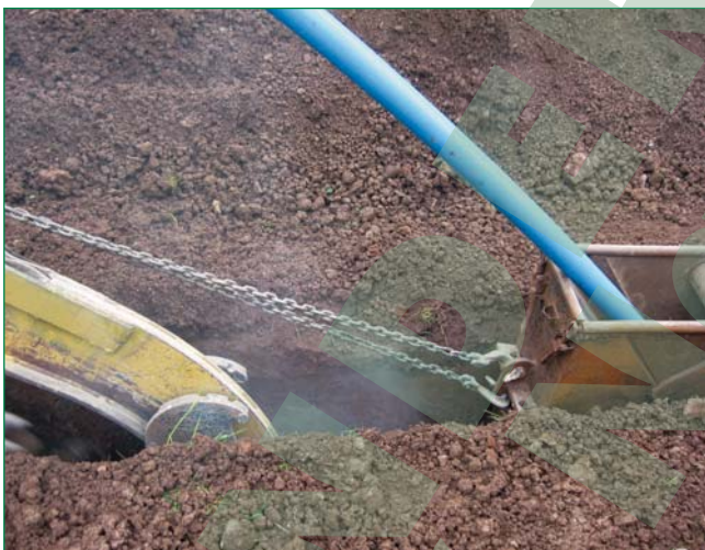
Bild 4: Das stabile PE-Xa Rohr ist für nahezu alle Verlegearten geeignet. Auch das Einfräsen in steinigem Boden ist mit diesem Rohrtyp einfach und sicher möglich
