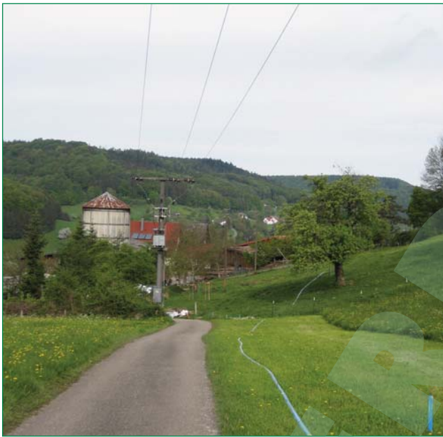
Bild 1: Insgesamt wurde eine Strecke von über 3.000 m zwischen zwei Hochbehältern mit einer neuen Trinkwasserleitung aus chemisch vernetztem Polyethylen (PE-Xa) Rohr verlegt
