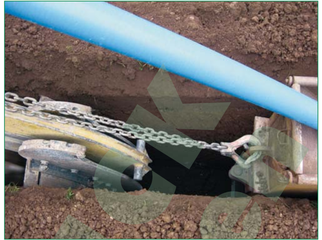
Bild 5: Mit einer Fräse wird passend zu der zum Einsatz kommenden Rohrdimension ein schmaler Rohrgraben hergestellt; die Erstellung der Grabensohle erfolgt dabei zentimetergenau
