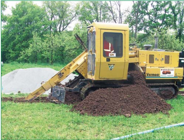
Bild 3: Für die Bodenklassen bis 6 wurde über große Strecken das PE-Xa Rohr mit einer 22 Tonnen Graben- und Felsfräse eingefräst
