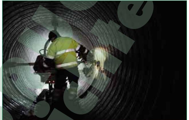
*Bild 1: Schweißer im Inneren eines PE Rohrs: Die Rohre können von der Innenseite her durch Extrusionsschweißen miteinander verbunden werden; der Schweißer ist dabei vor den äußeren Witterungsbedingungen geschützt – wichtig für eine schnelle Fertigstellung des Projekts im strengen finnischen Winter*
