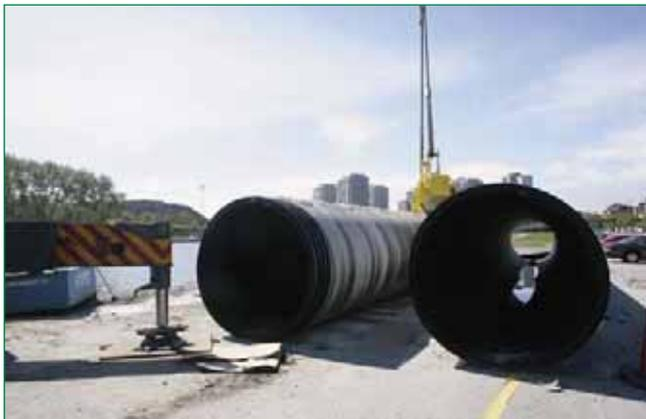
*Bild 2: Große PE 80 Rohre (DN/ID 2000 mm) verbinden die Wärmepumpenstation mit dem Meer; hier die Rohre vor ihrer Absenkung in den Graben*
