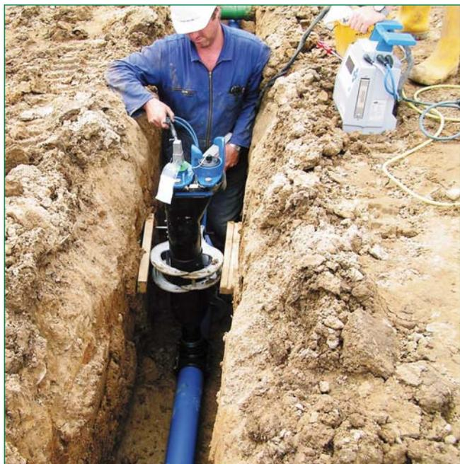
Bild 8: PE Hydrant – Installation direkt auf der Hauptleitung
