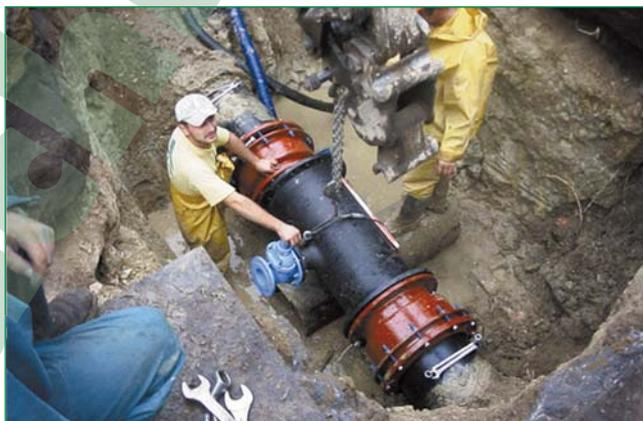
Bild 11: MULTI/JOINT-Kupplung im praktischen Einsatz
