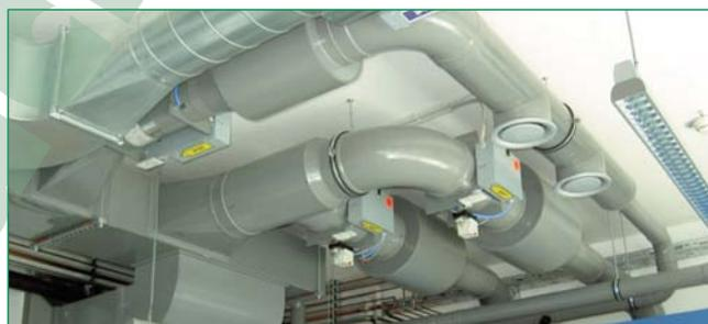
Bild 11: Beispiel für eine Abluftanlage aus Kunststoff
