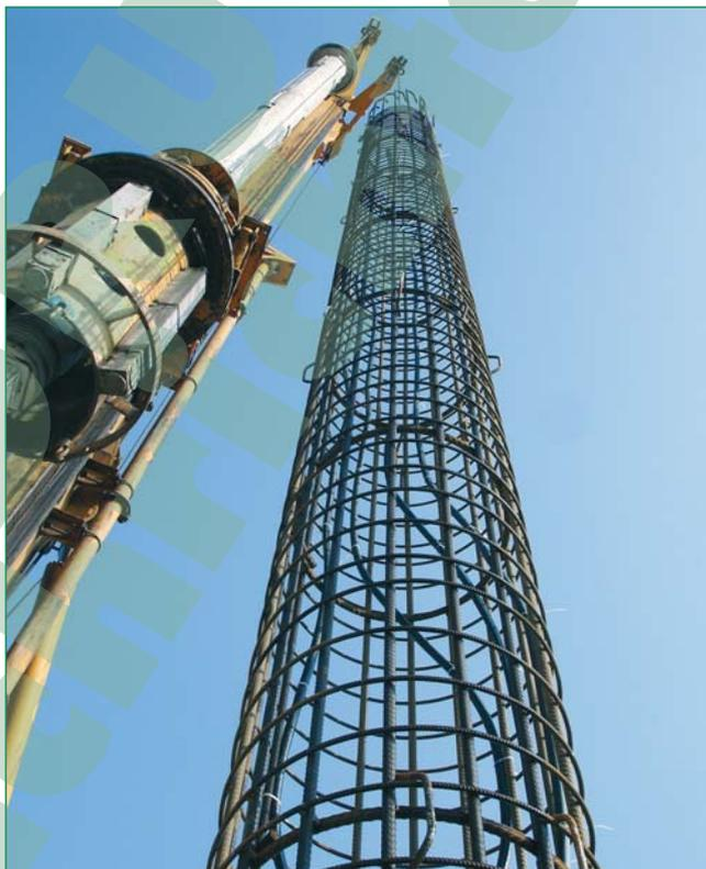
Bild 6: Detailansicht eines Energiepfahls am Kran
