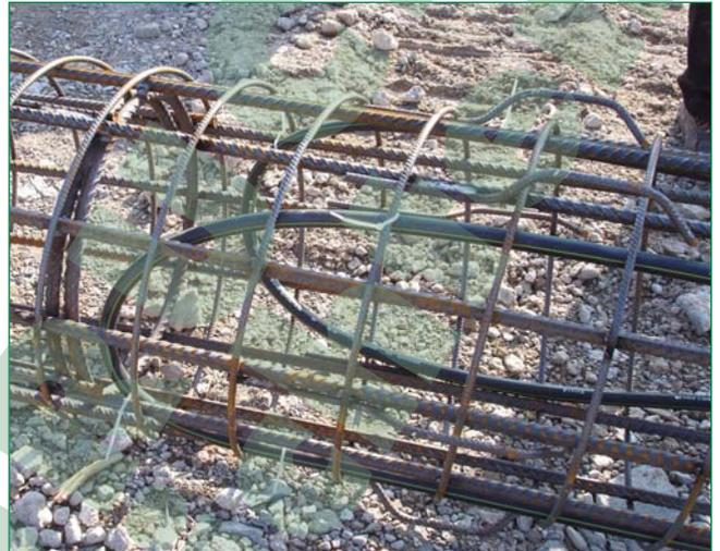
Bild 4: Bewehrungskorb mit installierten Energiepfahlwärmetauscherrohren; Foto: Gerodur
