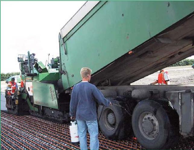
**Bild 4:** Das System Installationsplatte/Rohr ist befahrbar, wodurch der Einsatz üblicher Asphalt-Anlieferfahrzeuge und Straßenbaumaschinen möglich wird
