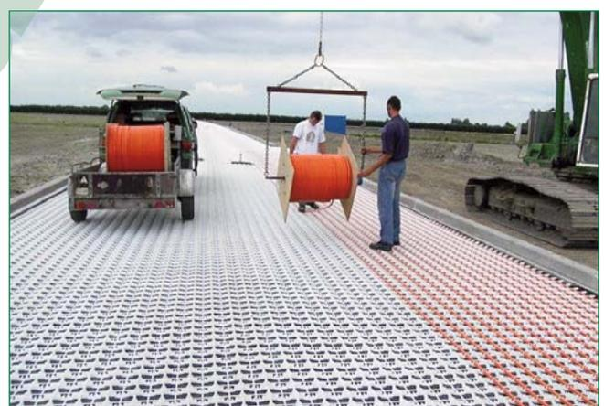
Bild 3: Die Installation der Rohre erfolgt von der an einer Traverse drehbar hängenden Rohrtrommel
