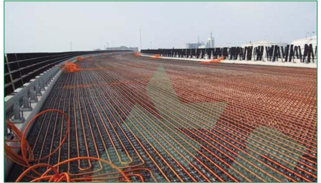
**Bild 5:** Bereits 2003 wurden in einer neu errichteten Autobahnbrücke im Gebiet des Hafens Rotterdam Rohrsysteme aus DOWLEX™ PE-RT/EVOH/PE-RT Rohren verlegt
