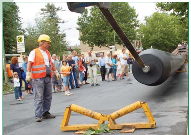
Bild 3: Mit leichtem Baugerät konnte der gesamte Rohrstrang zur Startgrube transportiert werden
