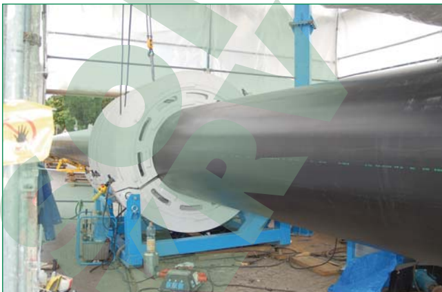
Bild 2: Die Rohrstränge wurden mittels Heizelementstumpfschweißung miteinander längskraftschlüssig verschweißt
