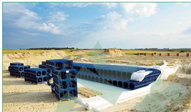
Bild 7: Einbau von Wavin Q-Bic; Foto: Wavin
