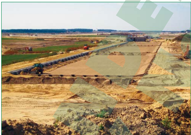
Bild 6: Rigolenbauwerk nach Erdüberdeckung. Deutlich zu erkennen sind die oberhalb des Rigolenspeichers befindlichen Mulden des Bodenfilters; Foto: Wavin
