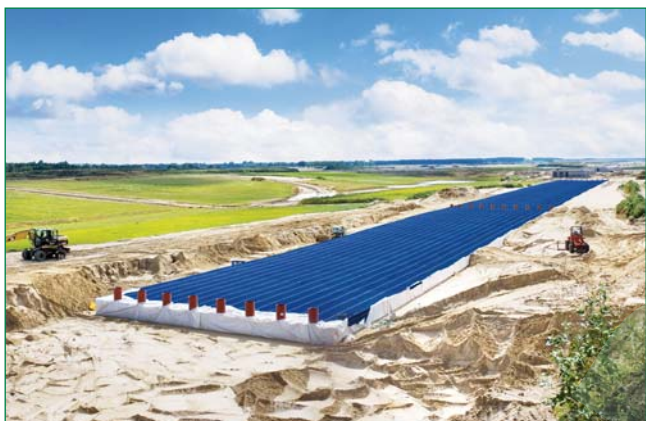
Bild 5: Sicht auf ein Rigolenbauwerk aus 18.700 Q-Bic Elementen: Es können rd. 8.000 m 3 Regenwasser zwischengespeichert werden. Große offene Wasserflächen, die einen Anzugspunkt für Vögel bilden könnten, werden hierdurch vermieden; Foto/Fotomontage: Wavin
