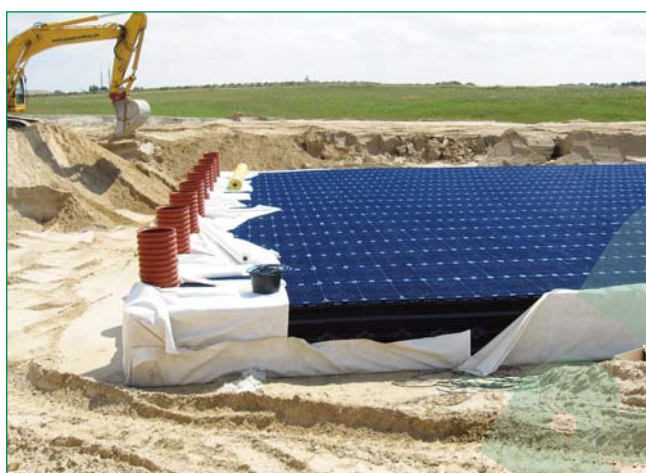
Bild 2: Aufgrund der Rigolenkonzeption und Rigolengröße konnte hier mit ungewöhnlich großen Geräten und somit äußerst produktiv gearbeitet werden; Foto: Wavin
