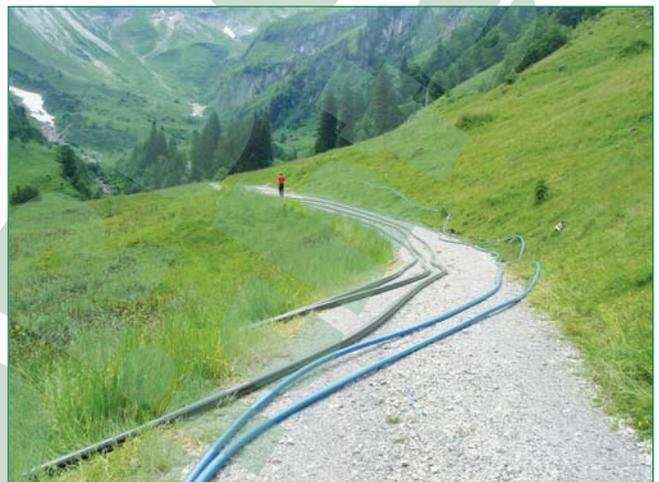
Bild 2: Die Rohre wurden mittels Schweißmuffen auf eine Trassenlänge von 350 m verschweißt
