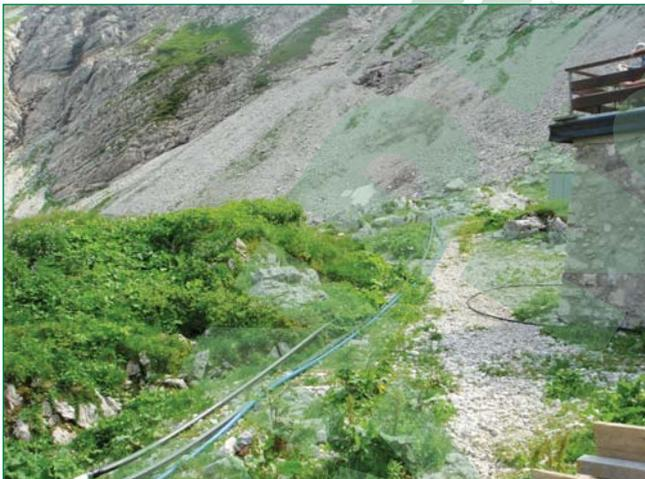
Bild 6: Die Rohrstränge wurden vom Helikopter entlang der Rohrtrasse abgelegt
