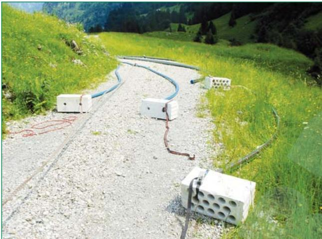
Bild 5: Zur Stabilität der Rohrstränge in der Luft wurden diese mit Steinen beschwert
