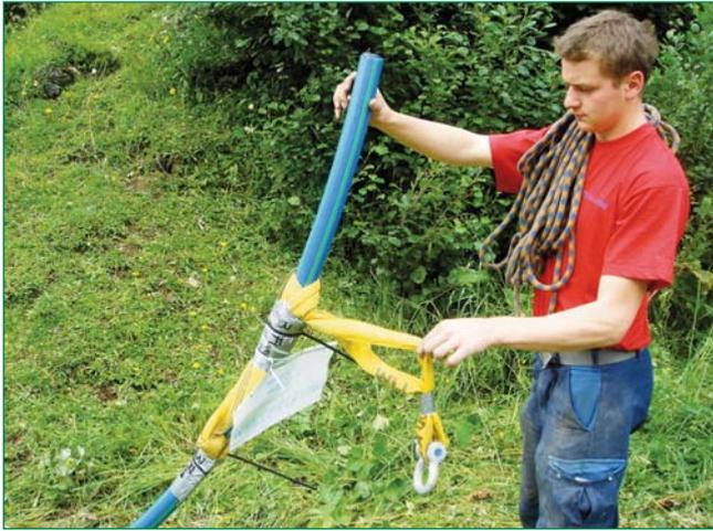
Bild 4: Die Rohrstränge wurden am Trageisil des Helikopters befestigt
