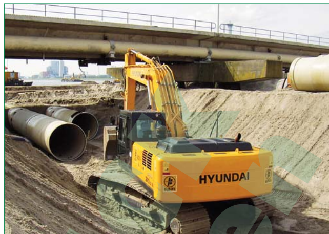
Bild 5: Installation eines Doppelrohrstrangs aus FLOWTITE-Rohren für die Niederschlagswasserableitung des JadeWeser-Ports
