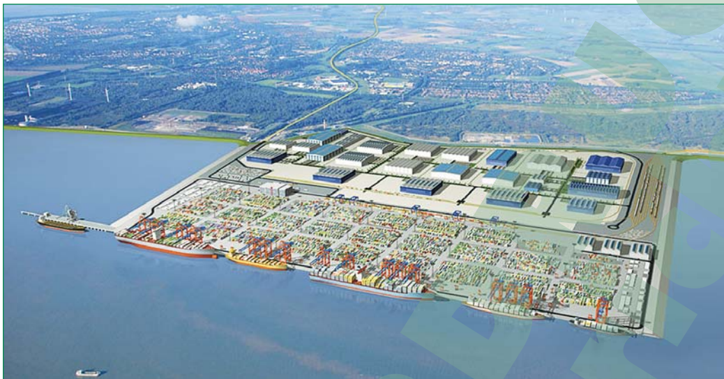
Bild 1: Der JadeWeserPort ist derzeit eines der großen und spektakulären Bauvorhaben in Deutschland
