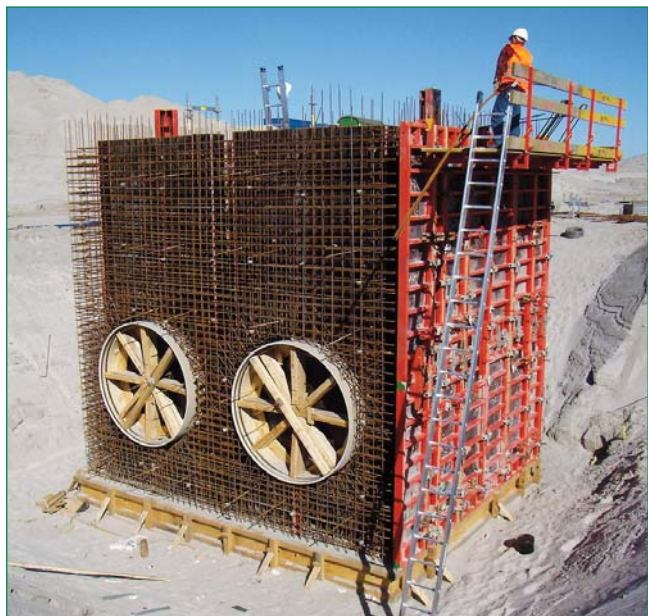
Bild 4: Schalung für ein Verteilerbauwerk mit integrierten GFK-Mauerwerkskupplungen
