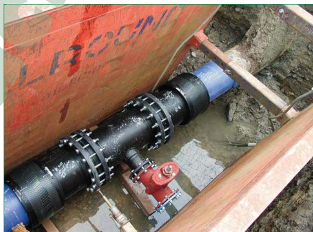
Bild 2: Installiertes Compact Pipe
