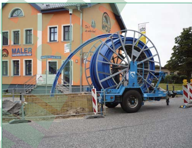
Bild 4: Einzug Compact Pipe
