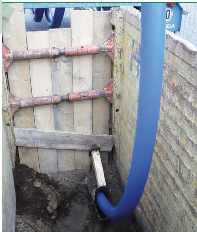
Bild 5: Detailaufnahme des Liner-Einzugs
