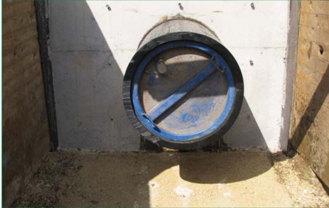
Bild 2: Inlinerstutzen ragt in der Einziehgrube aus dem Altrohr
