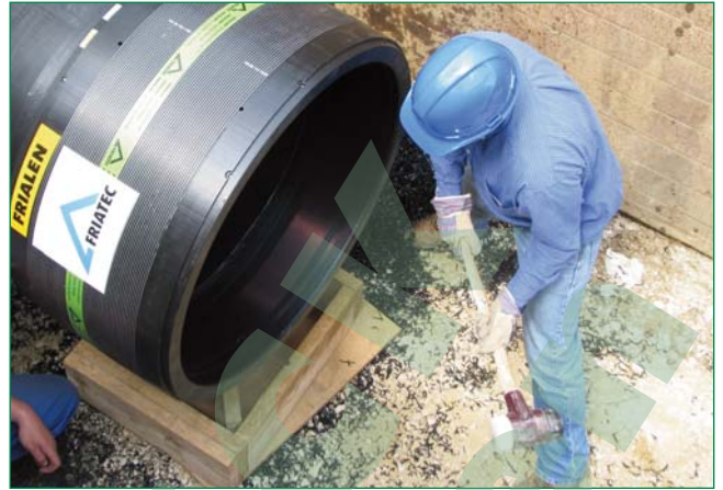
Bild 4: Montage der Muffe d900
