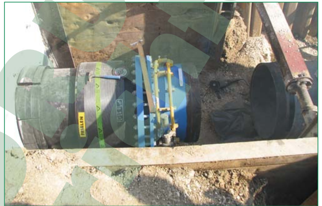
Bild 5: Fertiggestellter Werkstoffübergang PE/Stahl
