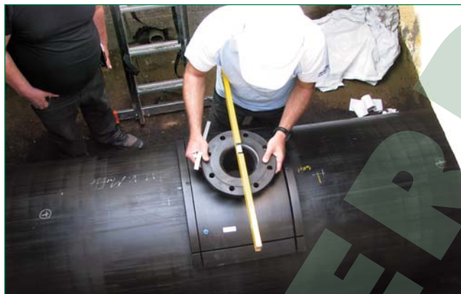
Bild 6: Ausrichten des Anschlussstücks SA-XL d900/DN150 für das Be- und Entlüftungsventil
