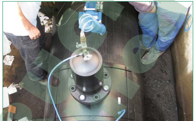
Bild 7: Schweißen des FRIALEN® Stutzensattels SA-XL d900/DN150
