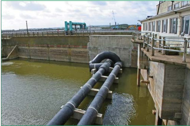
Bild 2: Zulaufleitung aus SIMONA PE 100 Großrohren
