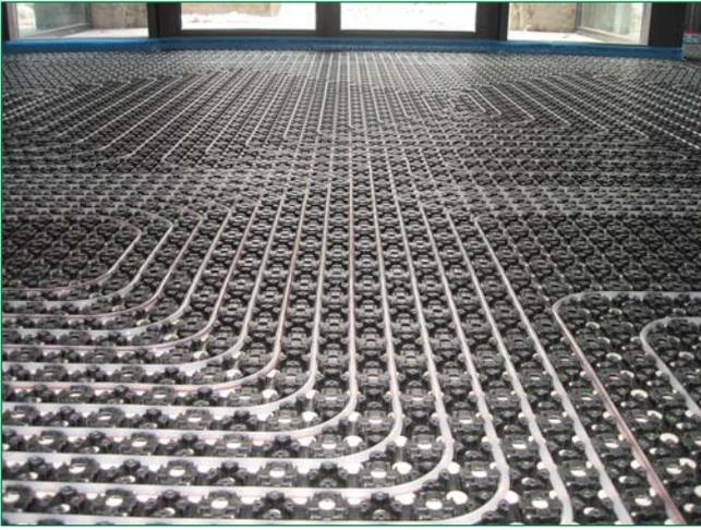
Bild 3: Speziell im Eingangsbereich war im Bodenaufbau eine geringe Aufbauhöhe gefordert; daher empfahl sich der Einsatz des Renovierungssystems Minitec mit einer Aufbauhöhe von lediglich 15 mm
