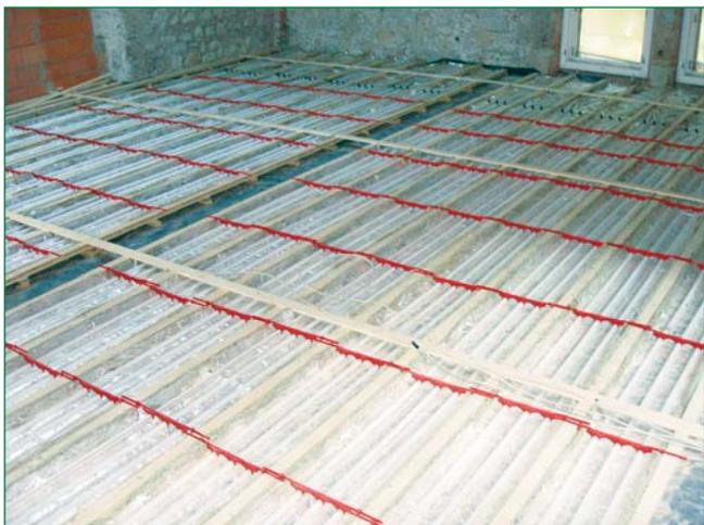
*Bild 4: Der Einsatz des Trockenbausystems Siccus empfahl sich insbesondere in den Gebäudeteilen, in denen kein Estrich im Bodenaufbau aufgrund baulicher und statischer Gegebenheiten möglich war*
