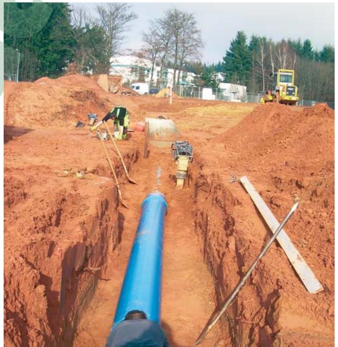
Bild 1: Verlegung des Primus HL SN 12
