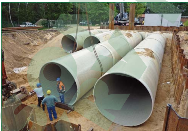
Bild 2: Die Montage von modularen Trinkwasserspeichern aus dem vergleichsweise leichten Werkstoff GFK bietet auch hinsichtlich der Bauzeiten erhebliche Vorteile gegenüber der herkömmlichen Beton-Bauweise
