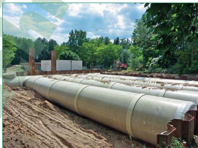
Bild 3: Der Speicher Klettwitz mit insgesamt 560 Kubikmetern Fassungsvermögen vor der Erdüberdeckung
