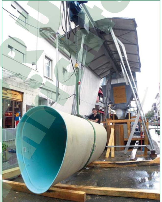
Bild 3: AMIREN®-Wickelrohr DN 700/1050 vor dem Absenken in die Baugrube
