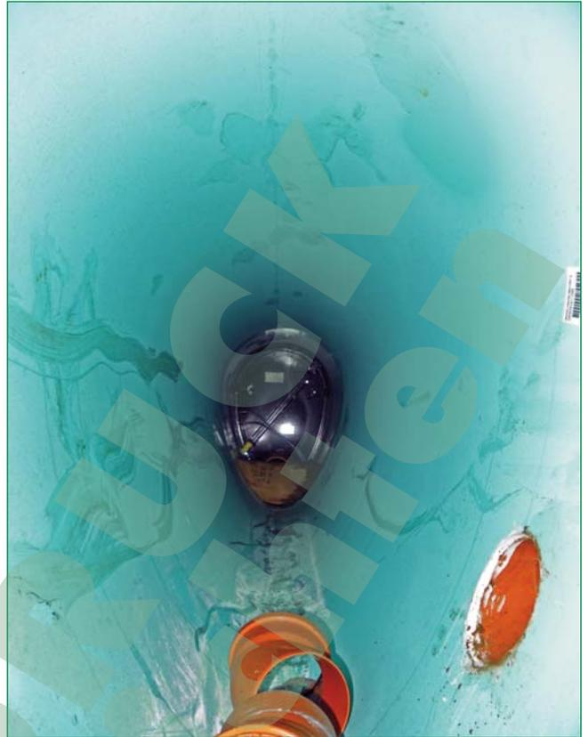
*Bild 6: Blick in den neuen Rohrstrang mit Hausanschlusseinbindung. Insgesamt 42 solcher Anschlüsse mussten während der Verlegung des neuen Kanals wieder hergestellt werden*
