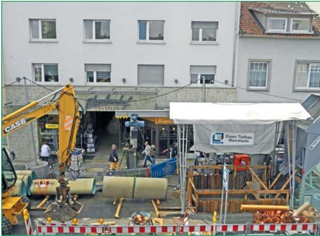
Bild 1: Bauprojekt in sensibler Lage: Von dieser Startbaugrube in der Mannheimer Innenstadt aus wurde ein Stollen bergmännisch aufgefahren, um darin anschließend eine neue Abwasserleitung aus AMIREN®-Wickelrohr zu verlegen
