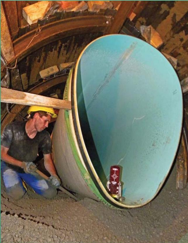
*Bild 5: Trotz der vergleichsweise leichten GFK-Rohre war ihre Ausrichtung unter den beengten Bedingungen im Stollen schwere Arbeit*
