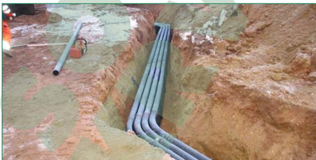
Bild 2: Verlegung von Kabelschutzrohren im Bündel 4 x 4 Rohre
