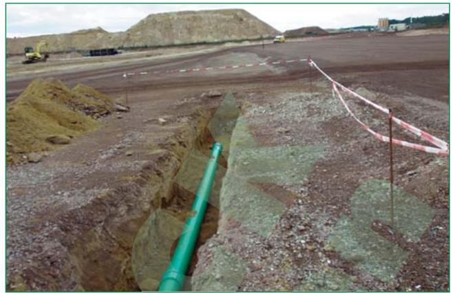
Bild 3: Einbau der Concept-HL Hochlastkanalrohre aus PP-HM
