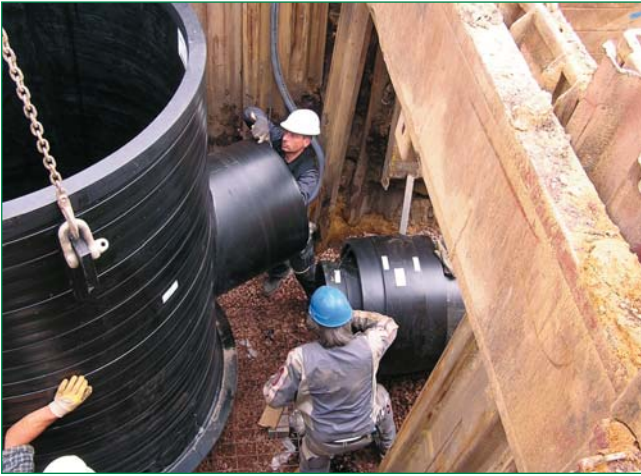
Bild 5: Ausrichten des PE-Schachtbauwerkes zur fachgerechten Herstellung der Verbindungsnaht an das Doppelrohr
