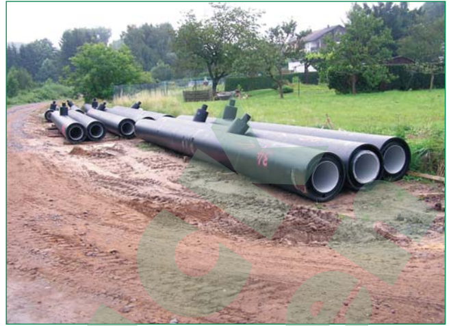
Bild 6: Doppelwandiges Rohrsystem mit exakt eingemessenen Hausanschlüssen
