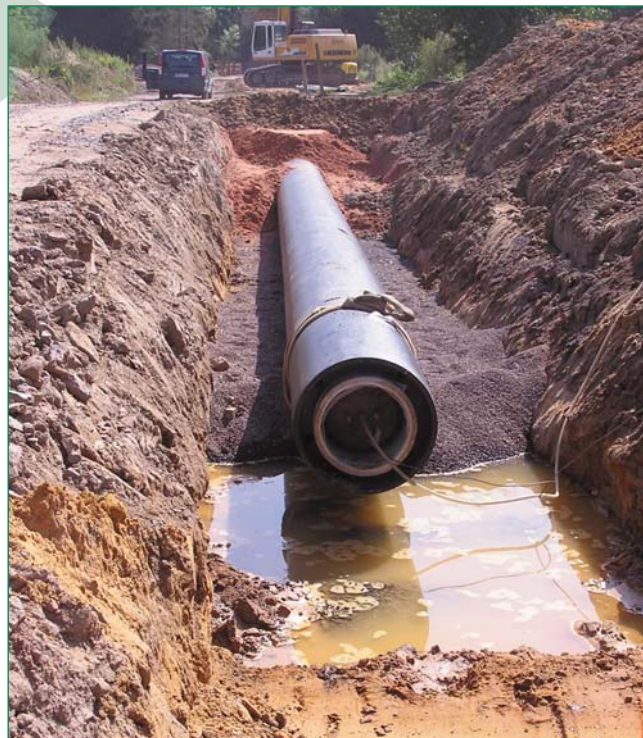
Bild 2: Haltungsweise Dichtheitsprüfung des Medienrohrs
