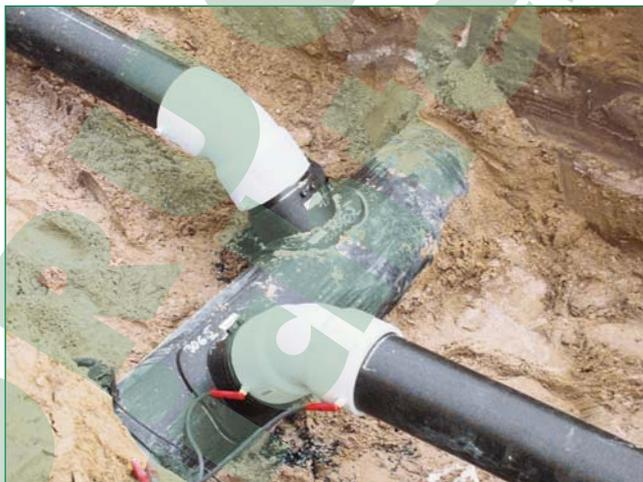
Bild 3: Die Hausanschlüsse und die Straßenabläufe wurden durch den Abwassersattel ASA-TL in Verbindung mit den Abwasserbögen ABM d160 angeschlossen
