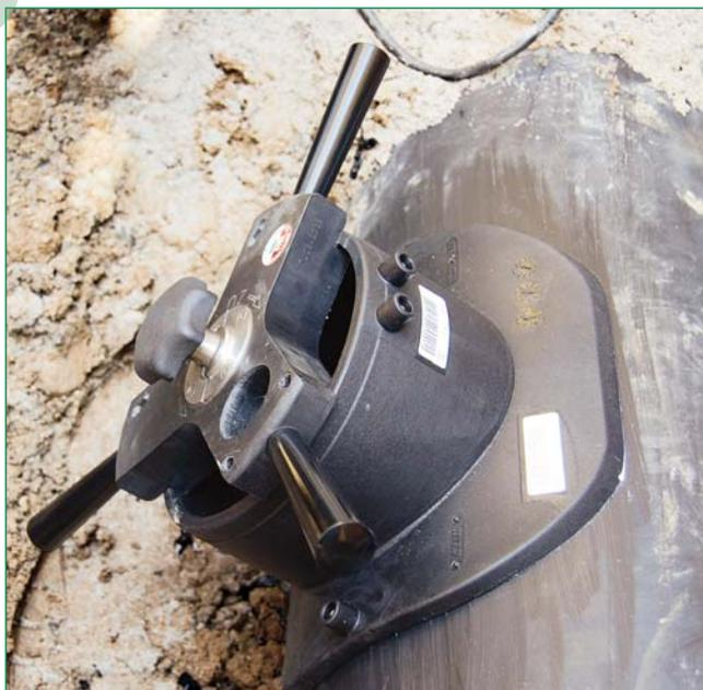
Bild 4: Präzise Montage der Abwassersättel ASA-TL mit dem kombinierten Aufspann- und Anbohrgerät FWFIT
