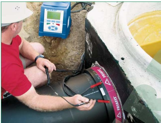
Bild 2: Einfache Anwendung mit dem kompakten Schweißgerät FRIAMAT
