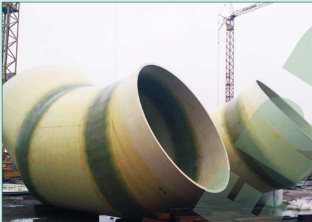
Bild 2: Segmentbögen DN 2600. Vorbereitung zur Anbindung an die Auslaufleitung
