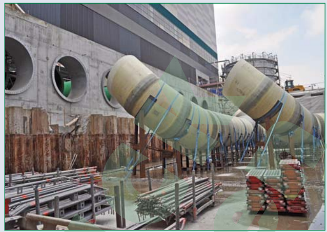
Bild 1: Die nach Maß gefertigten GFK-Wickelrohre wurden auf Stahlstützen in Endlage in der Baugrube fixiert; später wurden Rohre und Stützen samt dem nachfolgenden Vorlaufsystem in Beton eingegossen
